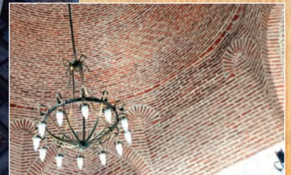
Harim mekânın tuğla kubbesinin görünüşü.
